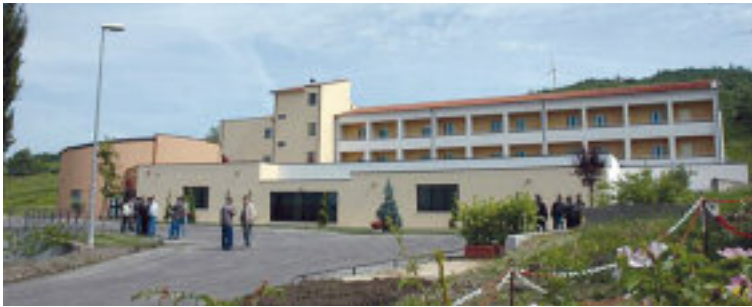
A sinistra: la casa di riposo costruita a Ripabottoni con il determinante concorso degli alpini. A destra: il taglio del nastro. In primo piano il sindaco, il presidente della Regione e due dei tre presidenti della Commissione Grandi Opere dell'ANA Ivano Gentili (di profilo) e Carlo Bionaz.
